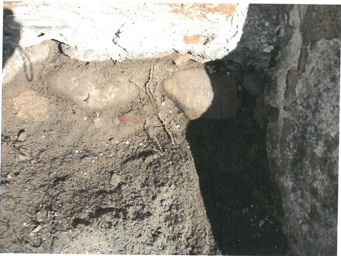
ZDJ.5 BAJKI ZALESIE KAPLICZKA DWORSKA. STAN W CZERWCU 2013 – FUNDAMENT
