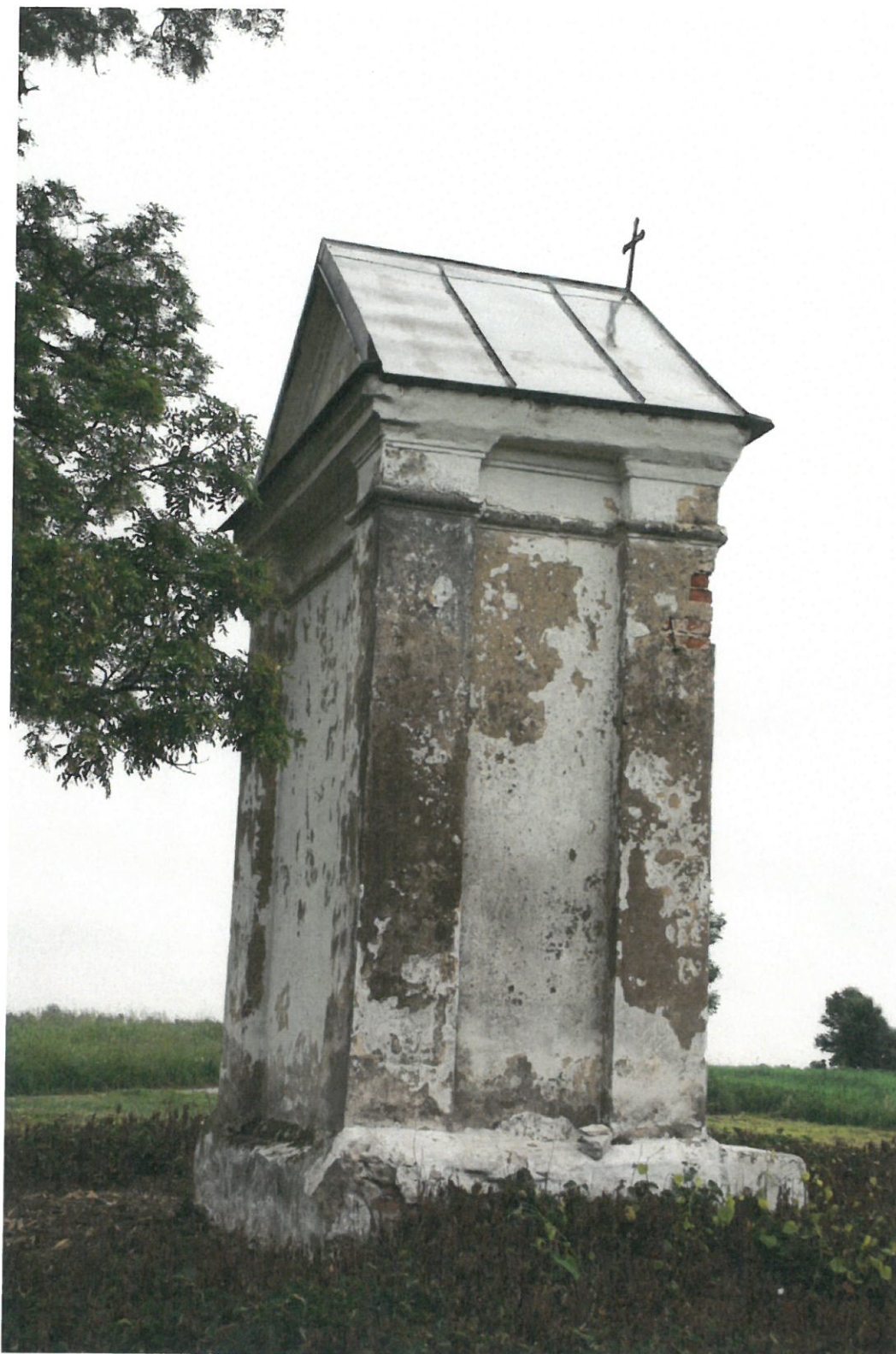
ZDJ. 2 BAJKI ZALESIE KAPLICZKA DWORSKA. STAN W CZERWCU 2013, WIDOK Z BOKU
